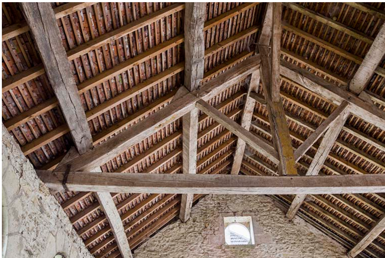
Charpente et oculus.
