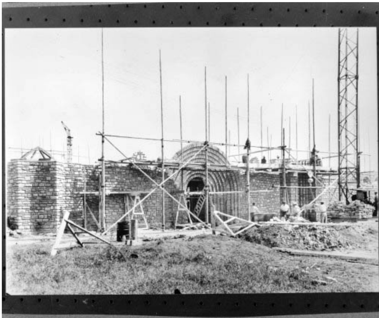
Travaux de construction de l'église, façade ouest.
