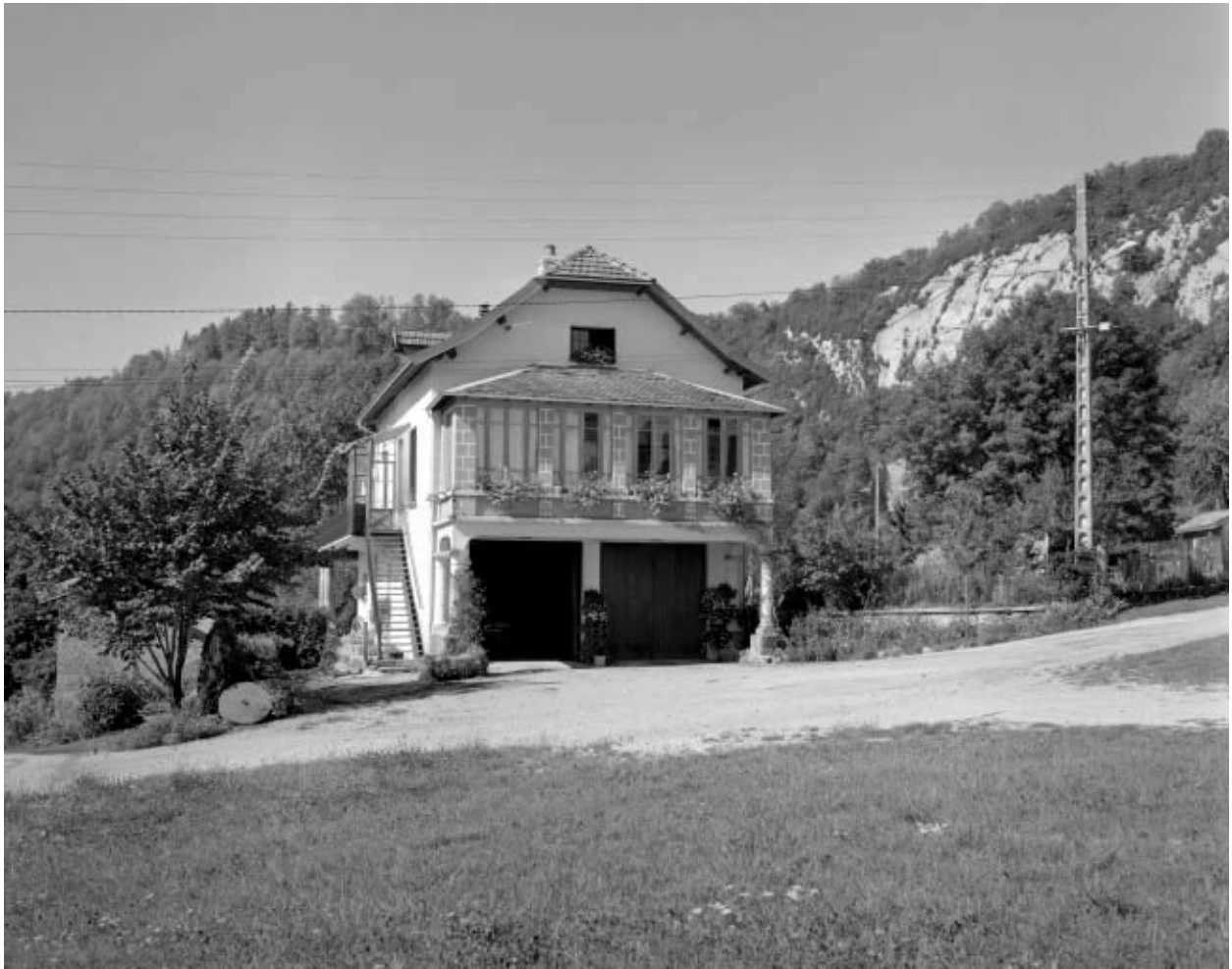
Logement patronal depuis l'est.
