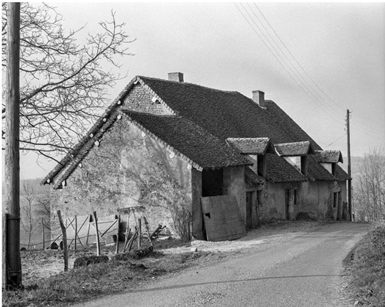
Maison située rue Bouillod.
