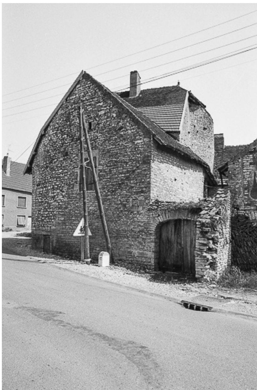
Maison située Au Village.
