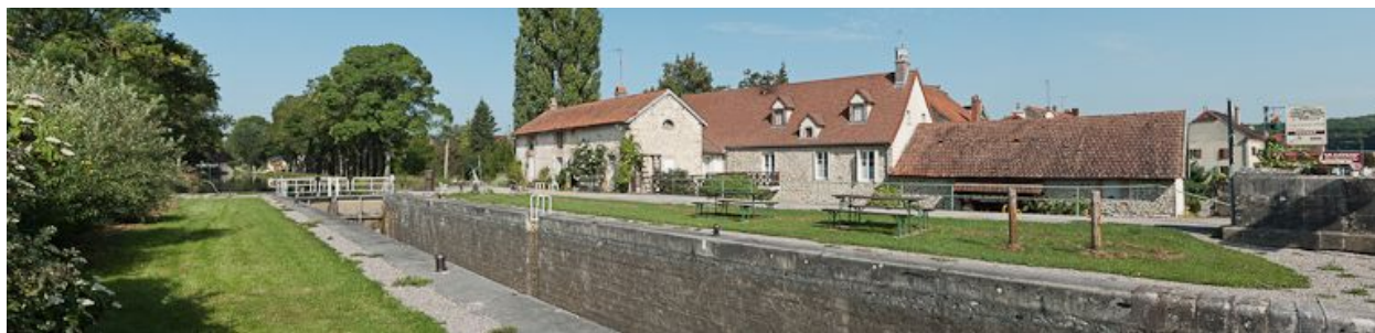
Vue d'ensemble du site d'écluse.
