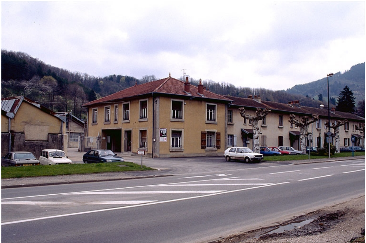
Entrée de l'usine depuis l'avenue.
