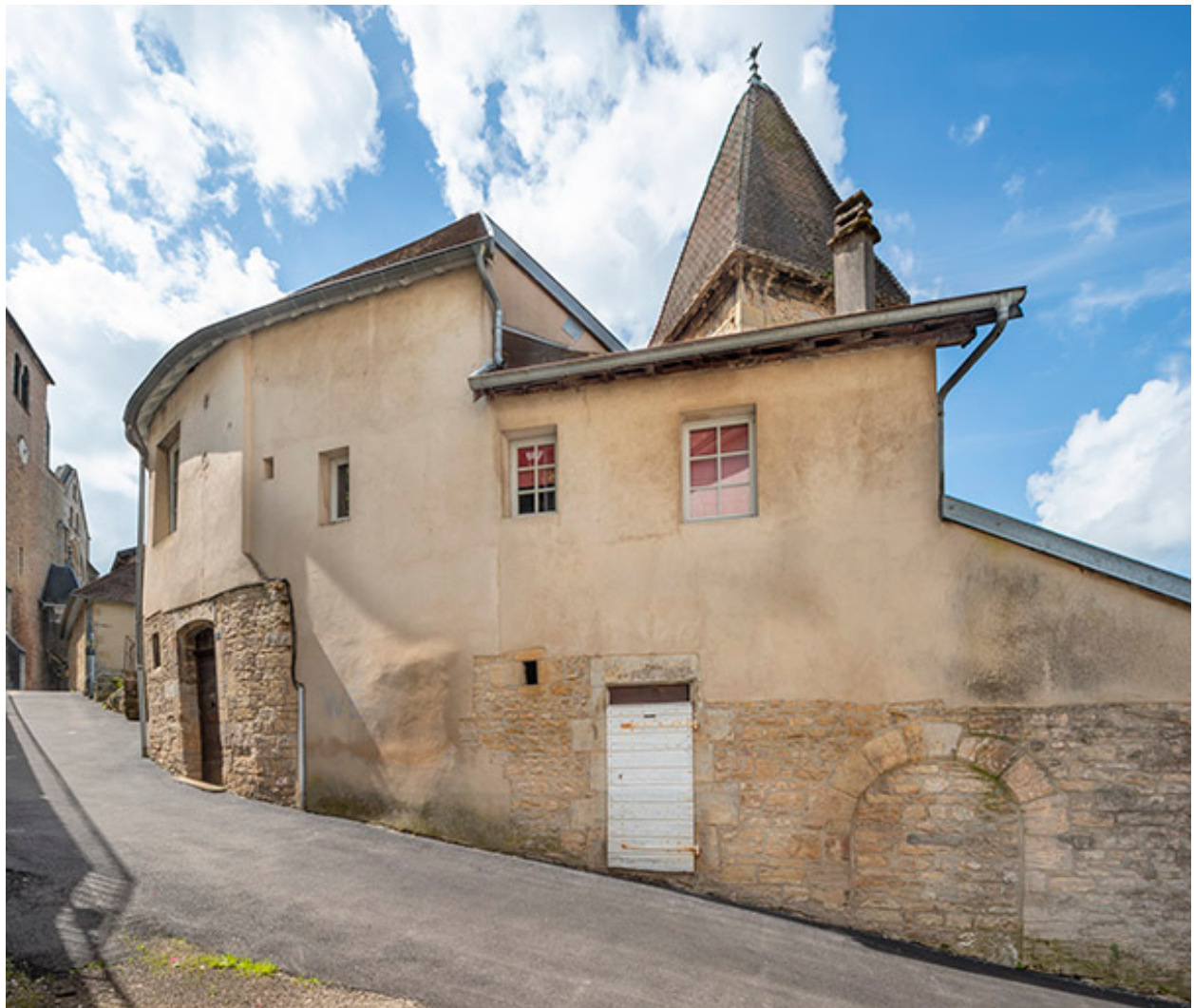
Façade nord, depuis la ruelle d'Arçon.
