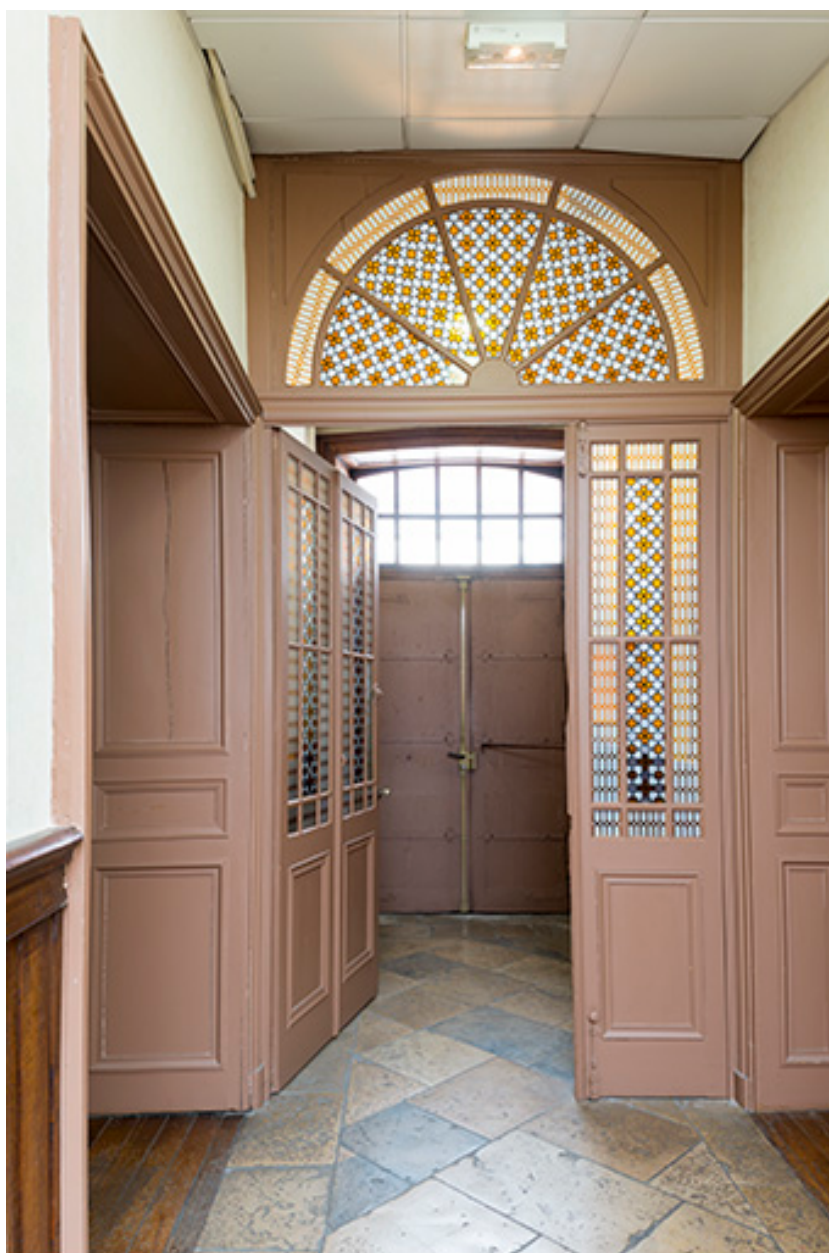
Le couloir et le vestibule (d'entrée).
