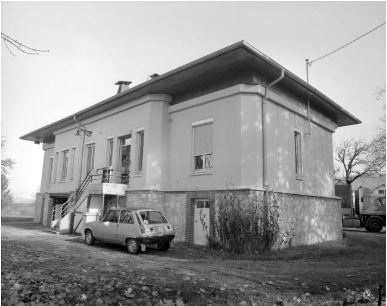
Façade postérieure vue de trois quarts droite.
