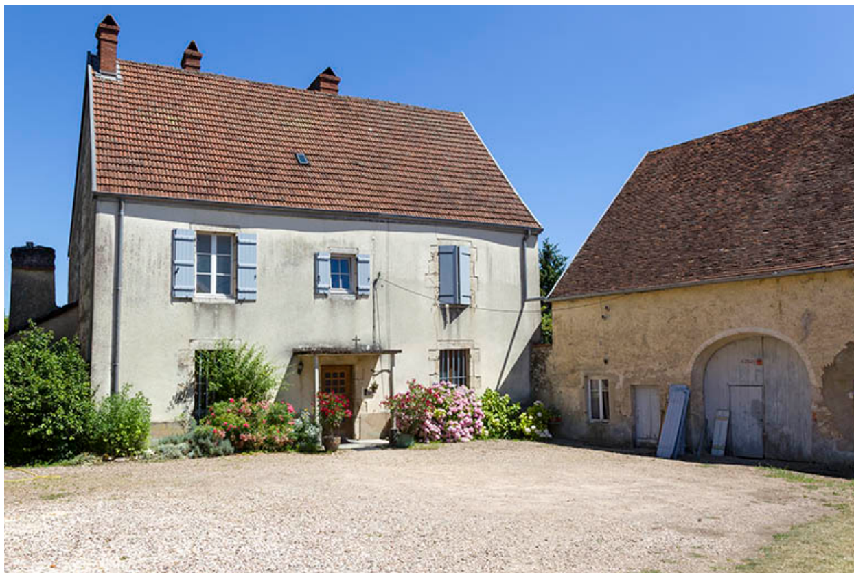
Vue d'ensemble depuis l'entrée.
