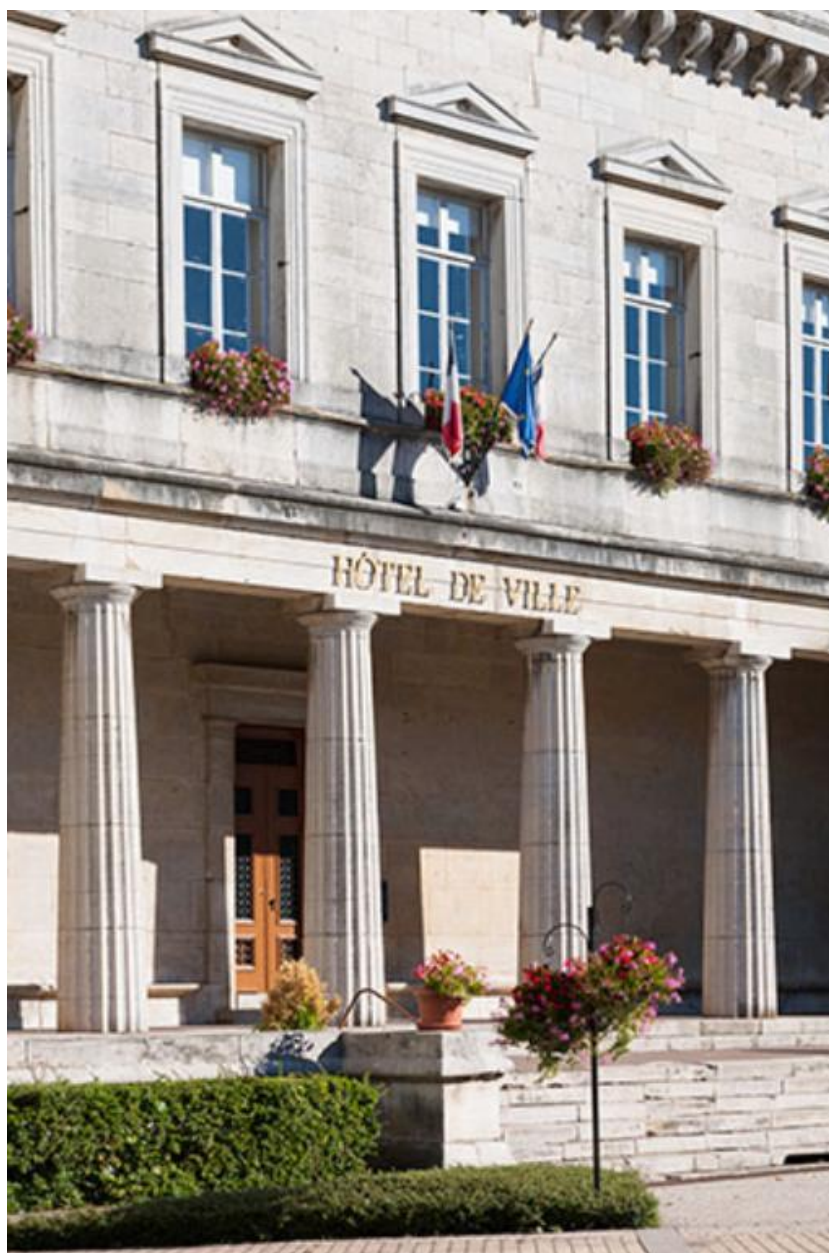
Vue sud-ouest du porche
