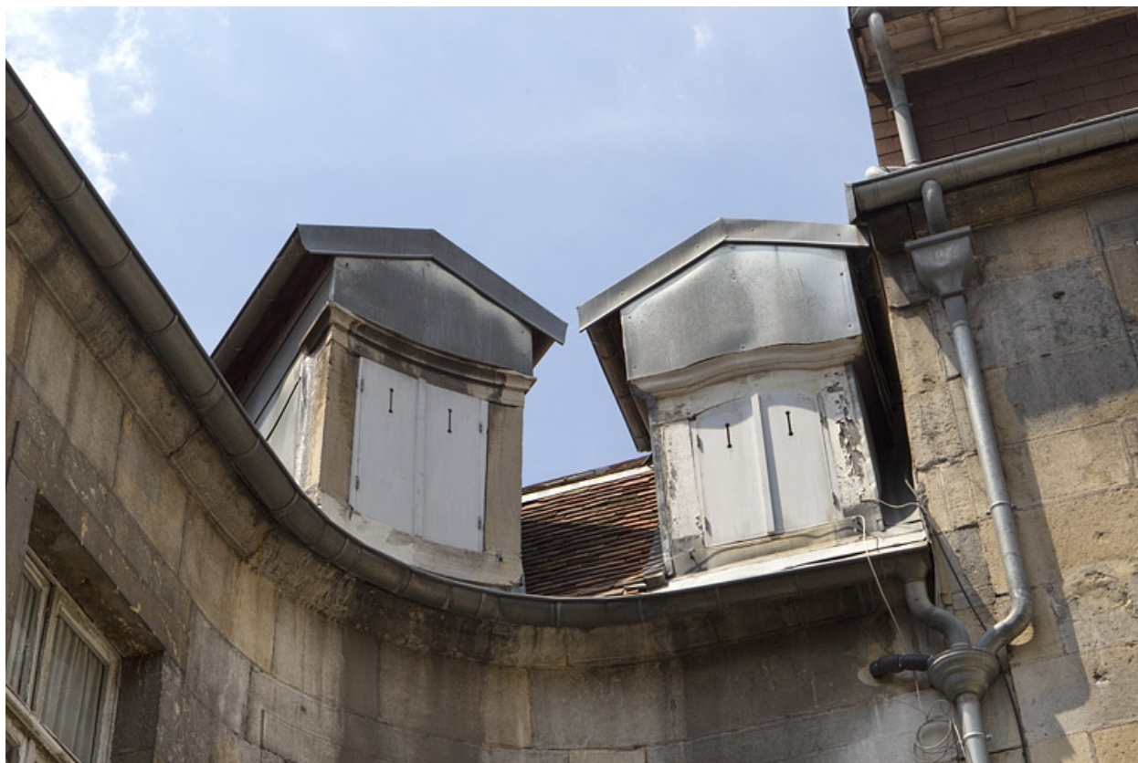
Logis principal : détail de deux lucarnes.
