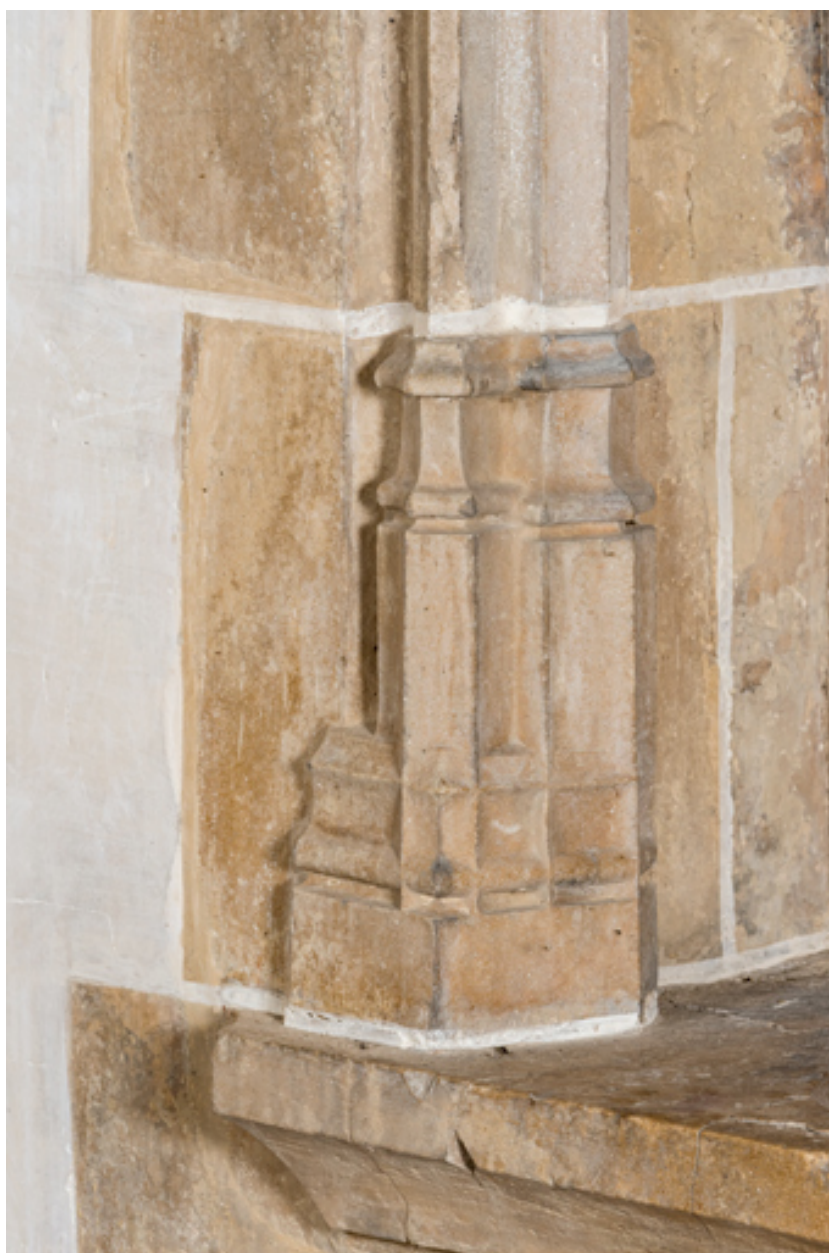
Détail : bases prismatiques des piédroits.
