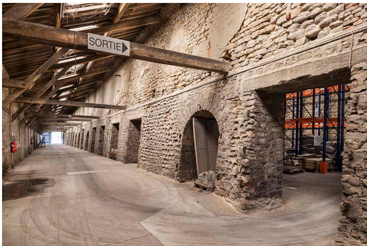
Saline de Châtillon-le-Duc, Geneuille : ancien quai de chargement.
