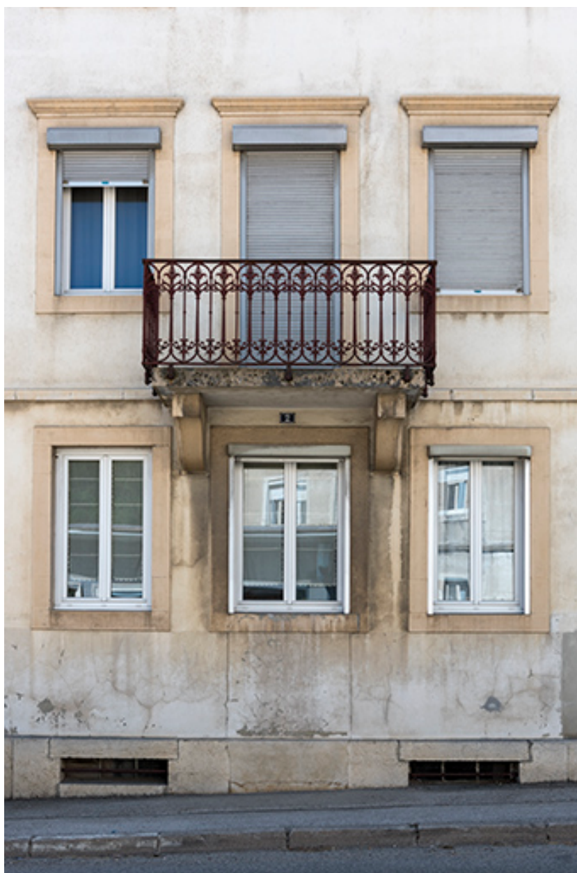
Façade antérieure : travées centrales.
