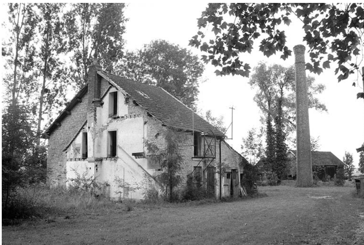
Ecuries (G) et cheminée d'usine (F).
