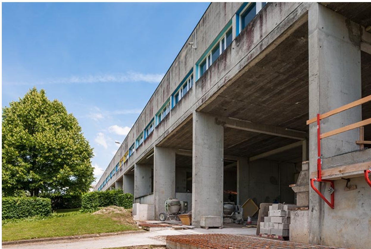
Externat : façade postérieure.
