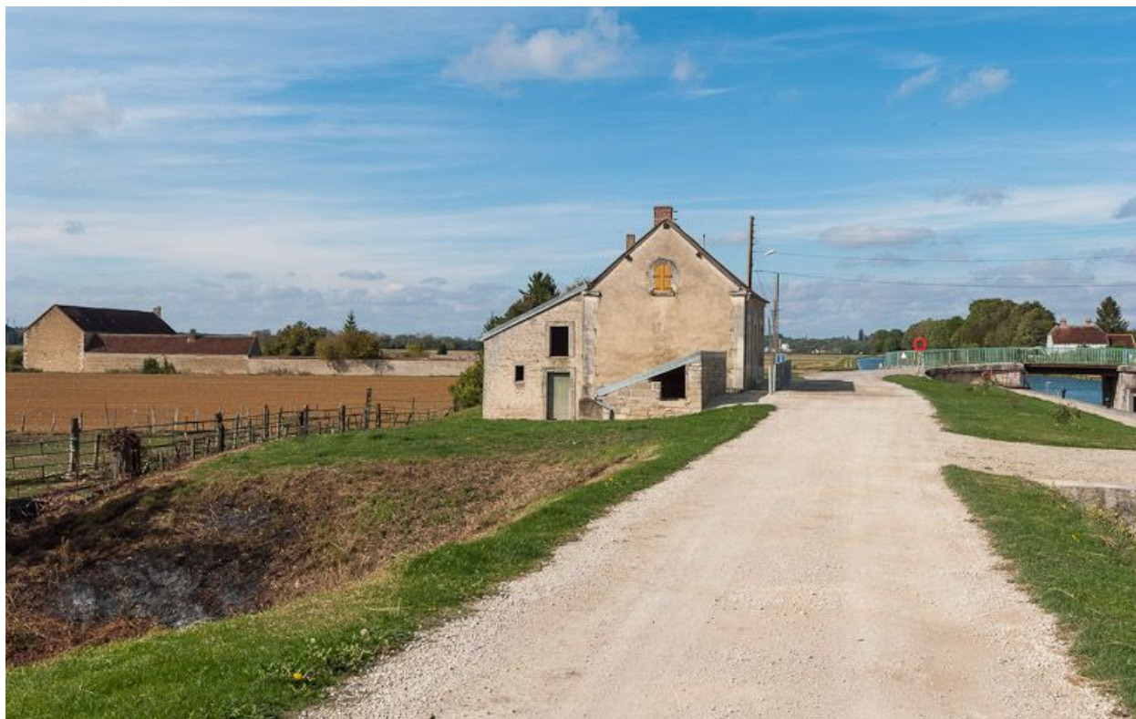
La maison éclusière avec ses appentis.
