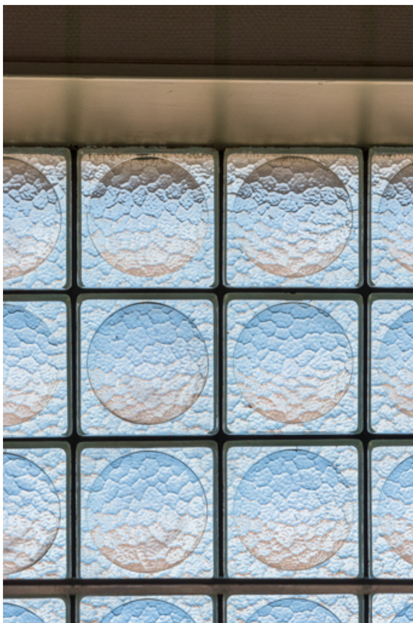
Cage d'escalier : détail des pavés de verre.
