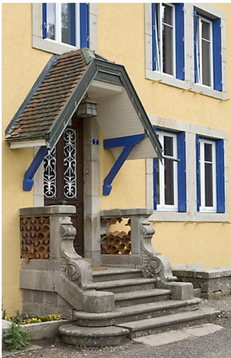
Logement principal. Le perron.
