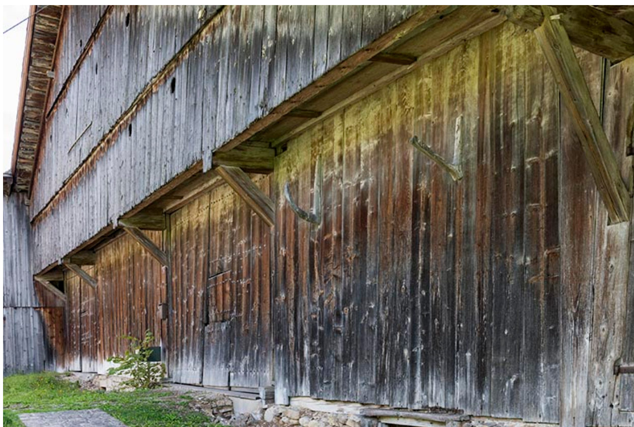
Façade ouest, vue en enfilade.
