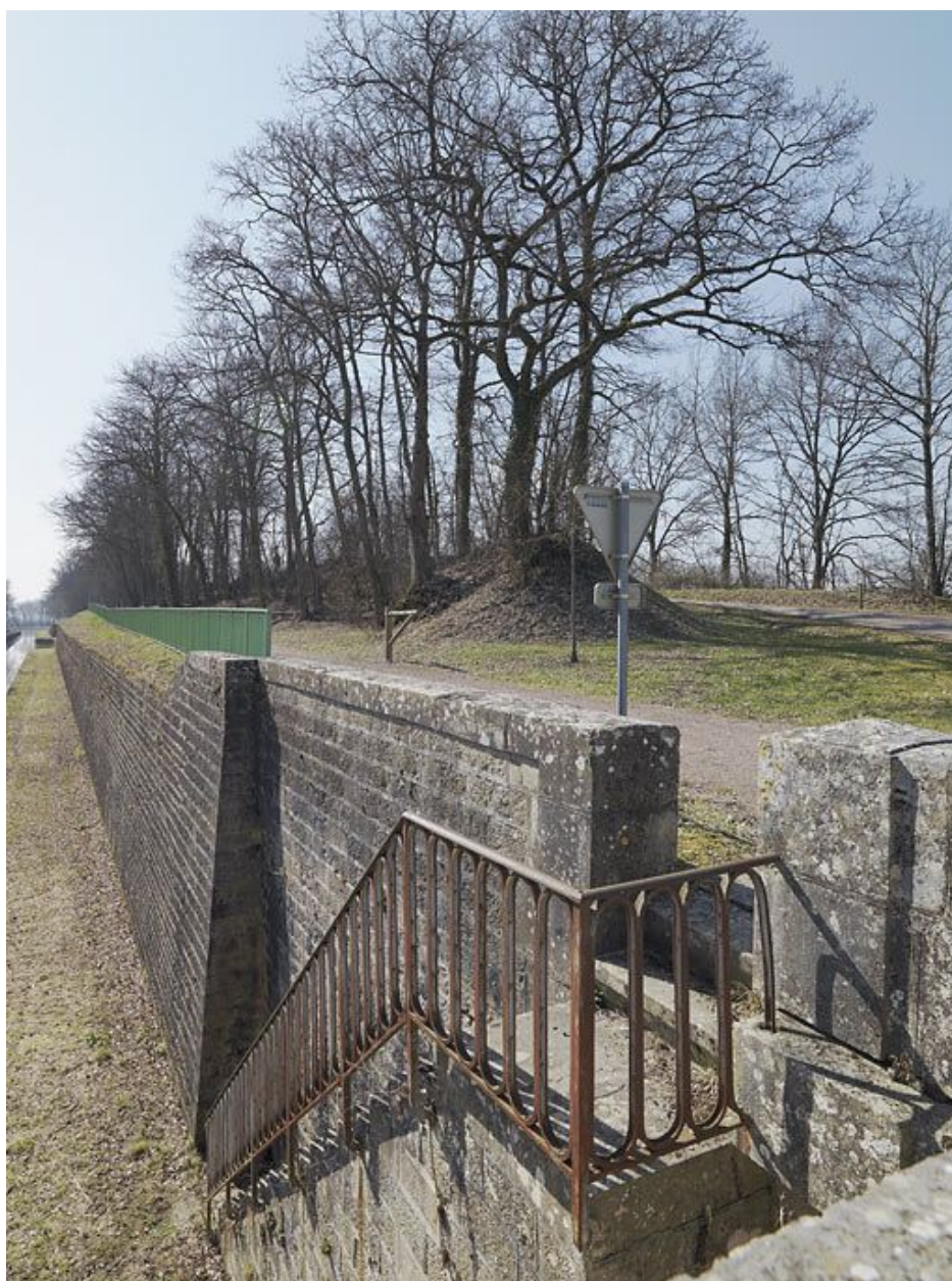
Escaliers d'accès au pont.
