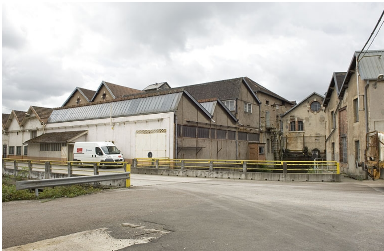
Atelier de fabrication (papeterie) et bâtiment d'eau.
