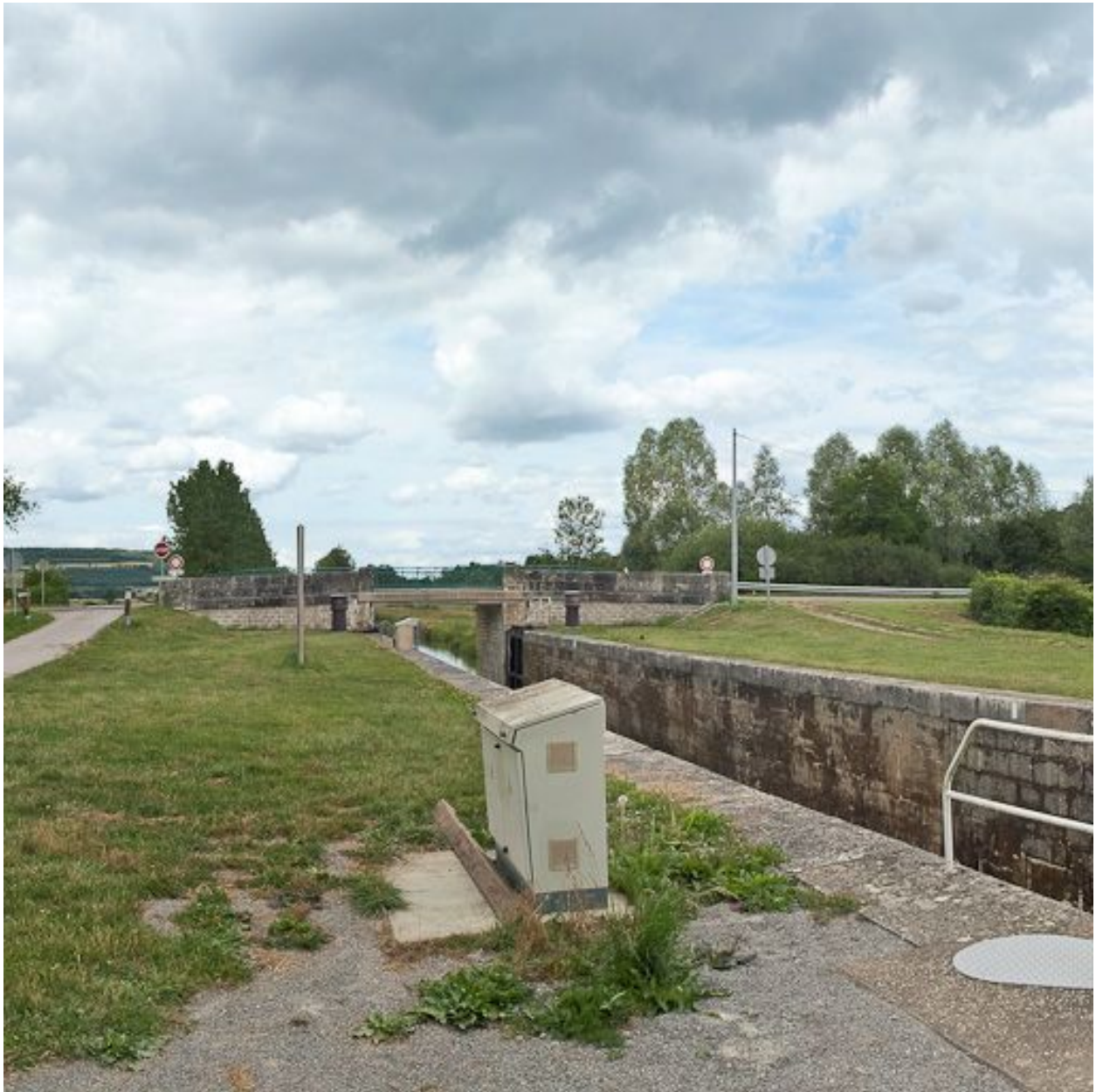
Vue du pont depuis l'amont.
