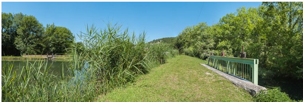
Vannes de l'aqueduc.
