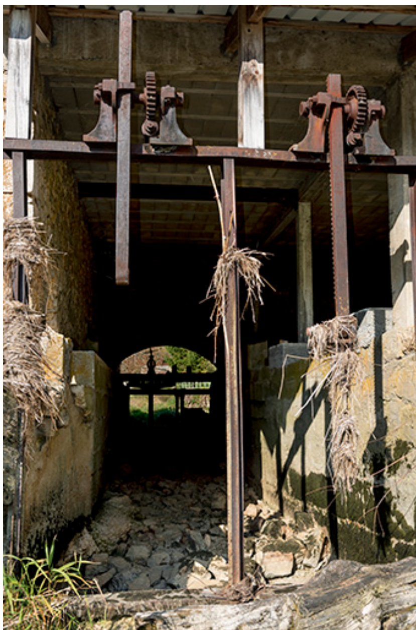
Moulin : vestiges des vannes de prise d'eau gauche.
