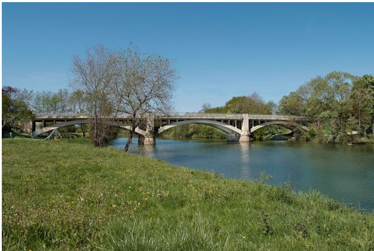
Pont routier sur la D933.
