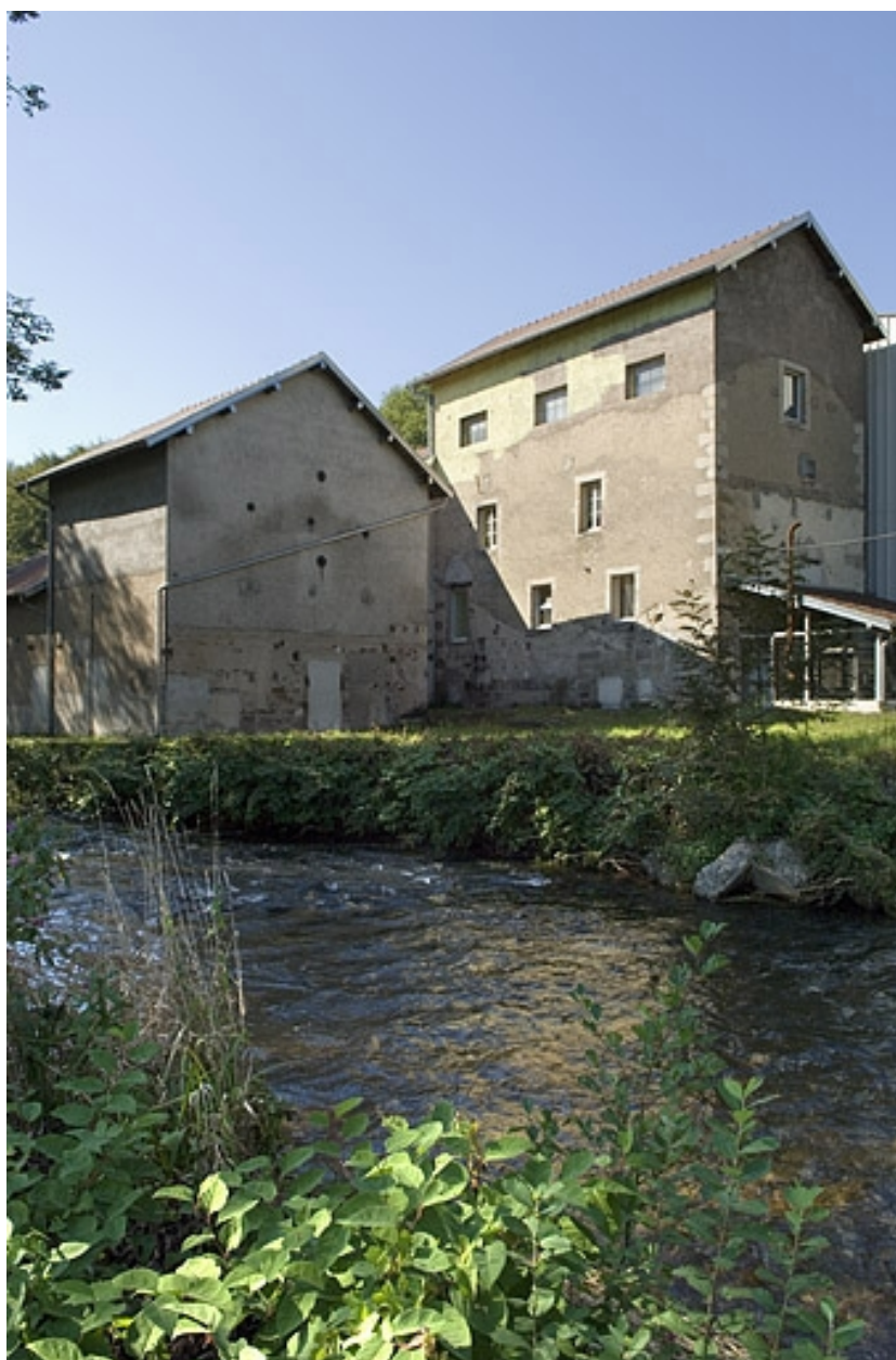
Elévation sud. Vue de trois quarts arrière.
