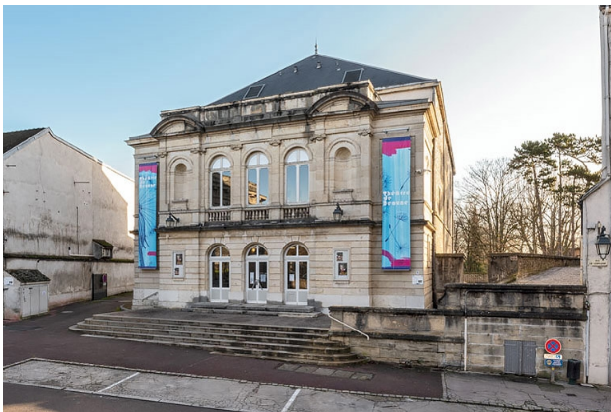
Vue d'ensemble sur la rue de Lorraine.
