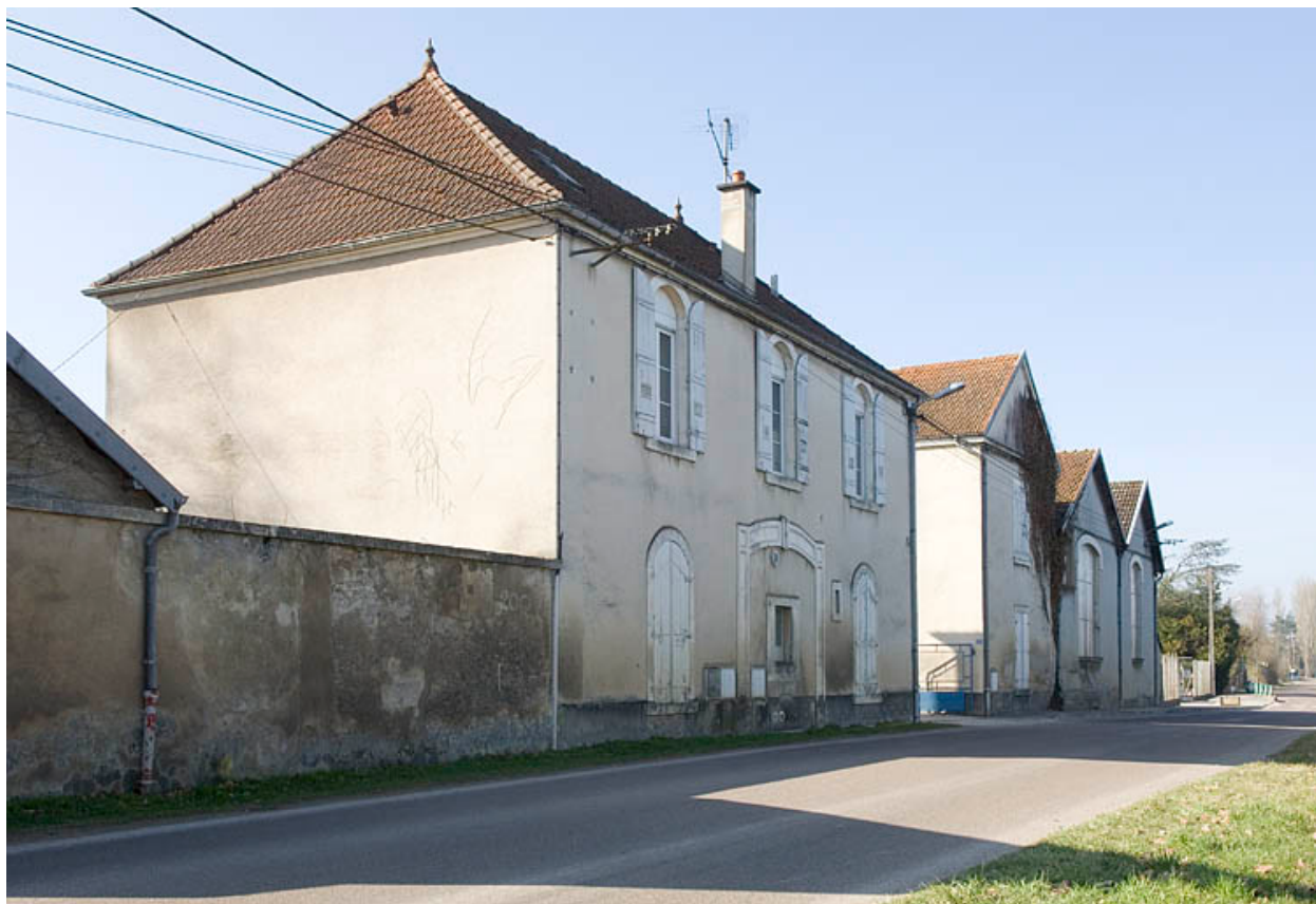
Vue d'ensemble depuis le quai Mavia.
