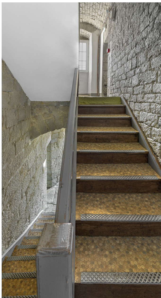
Caserne U : escalier tournant vers l'étage carré.
