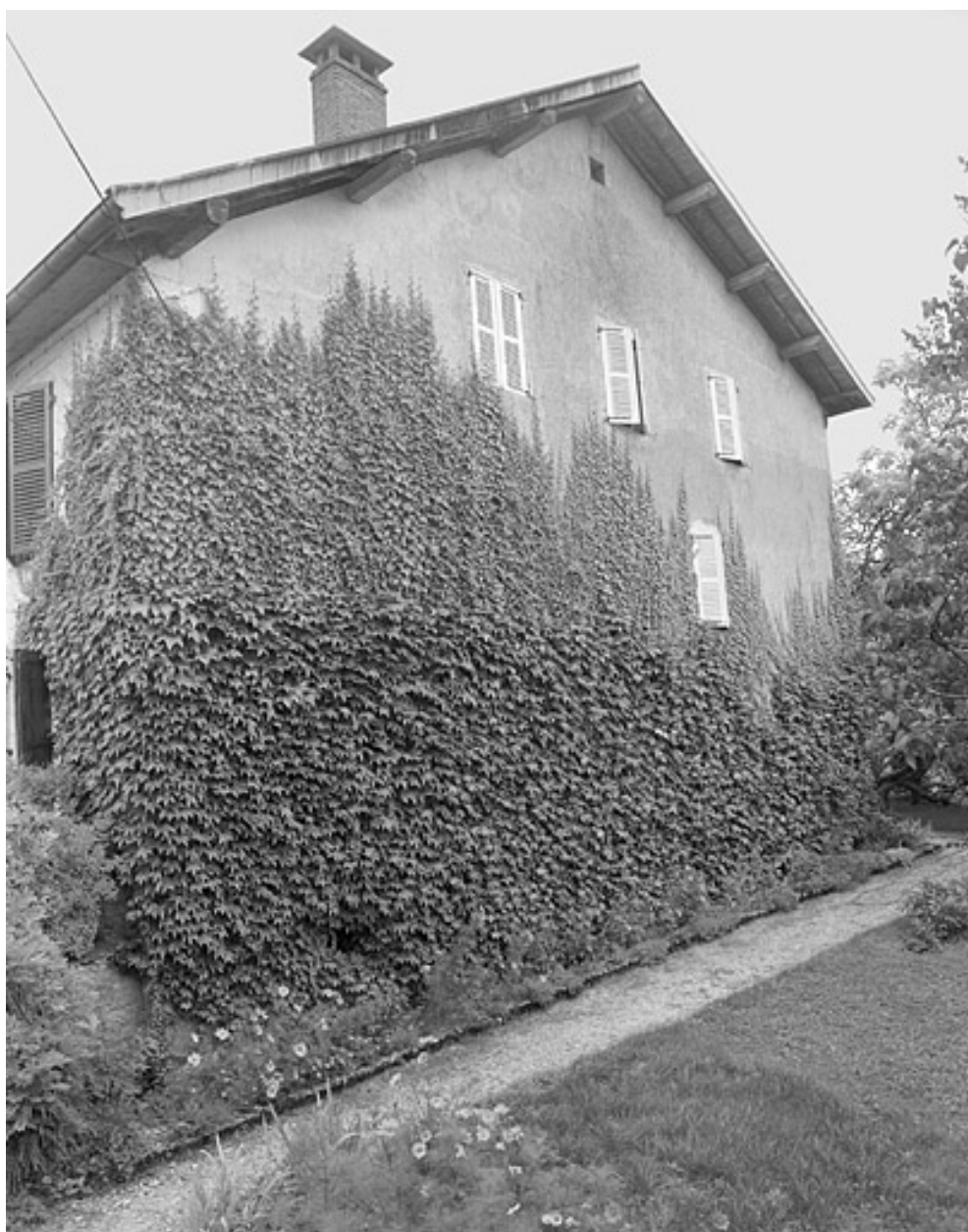
Face sud de la ferme.
