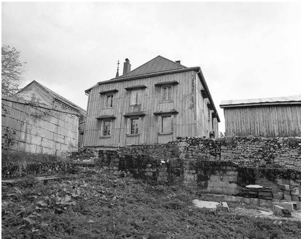
Vue éloignée de la façade ouest.
