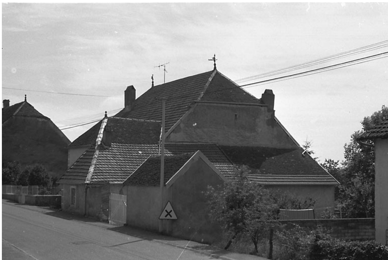
Façade latérale droite.
