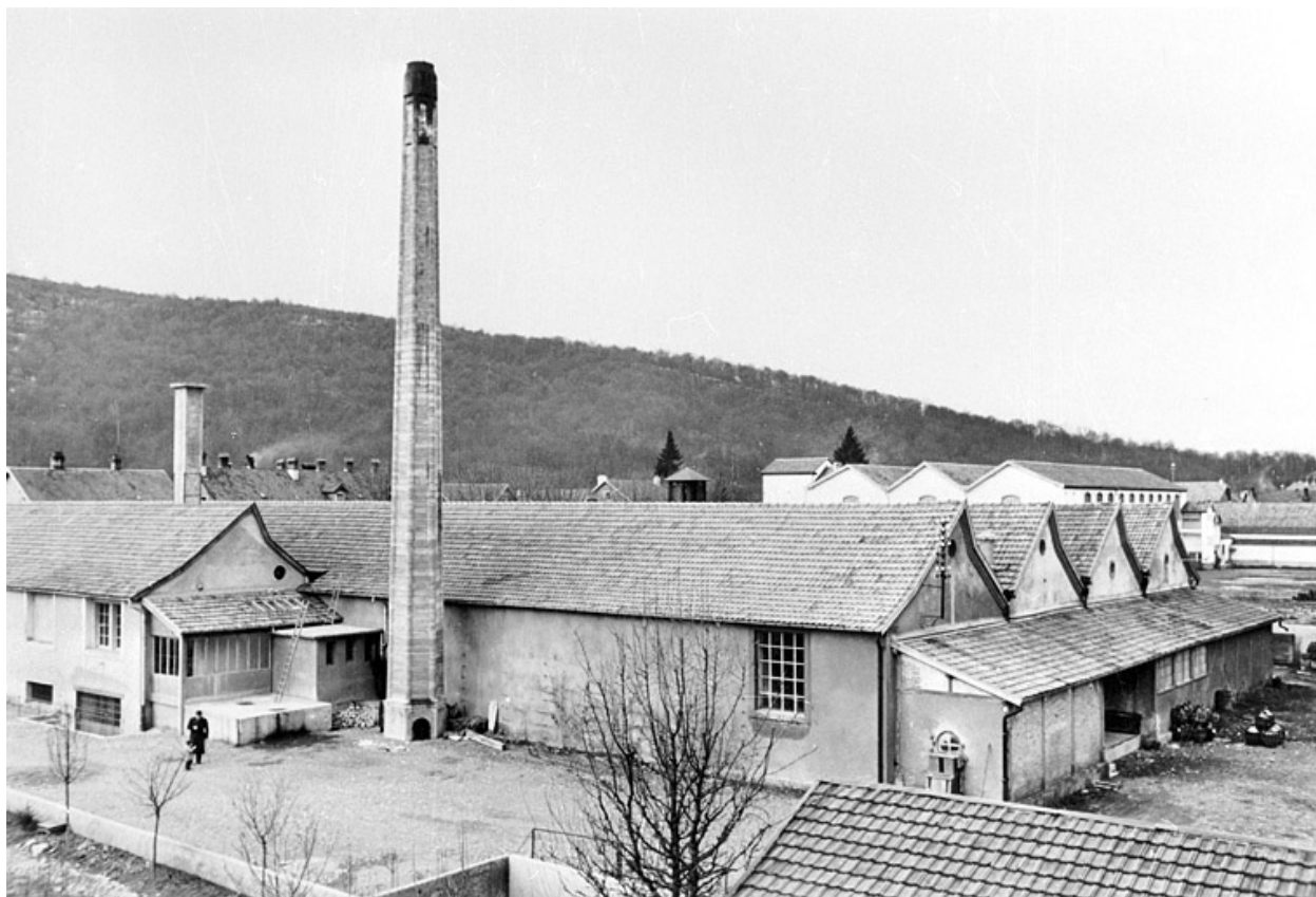
Vue d'ensemble depuis le sud-est vers 1945.
