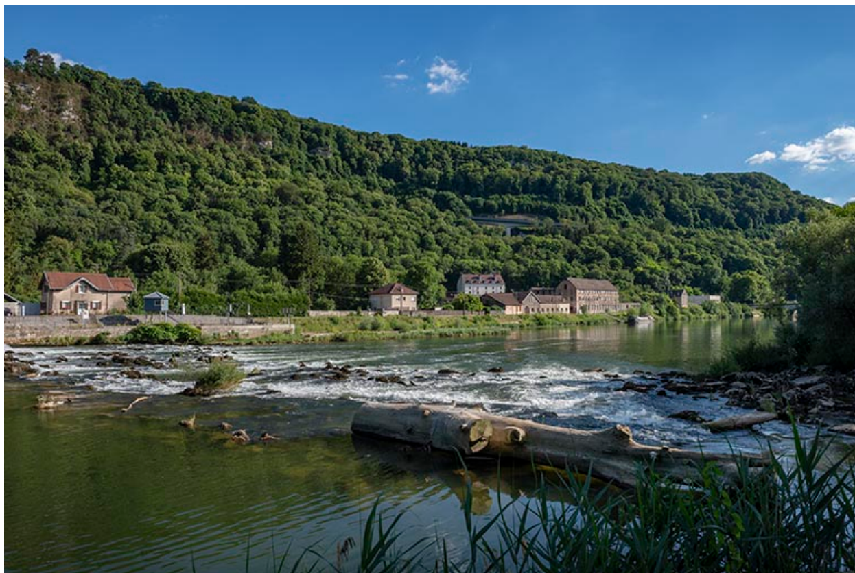
Vue d'ensemble depuis le nord-est (cadrage horizontal).
