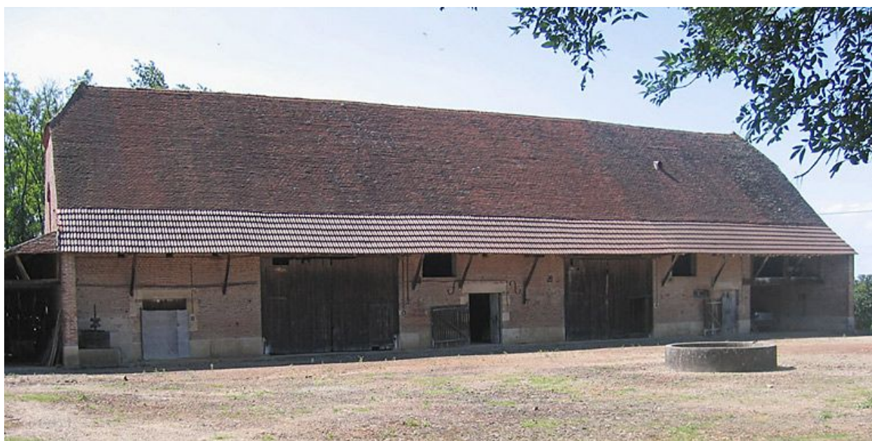
Vue d'ensemble de la façade.
