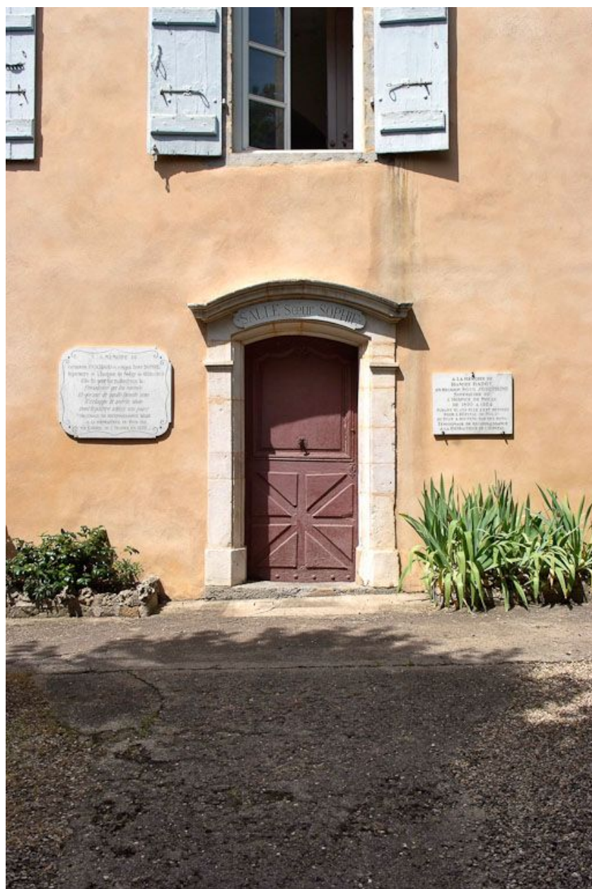
Façade antérieure, détail de la partie centrale.
