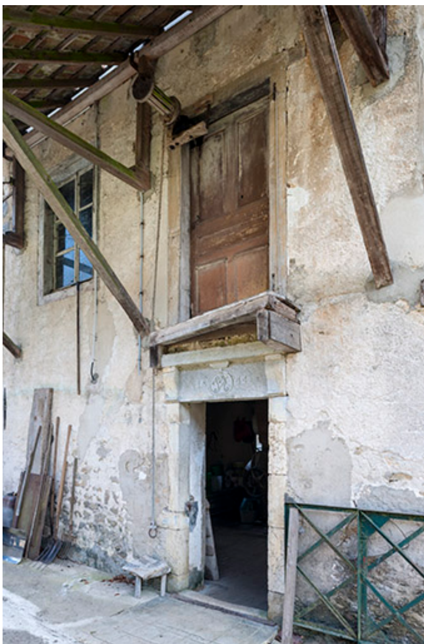
Mur-pignon ouest vu de trois quarts.
