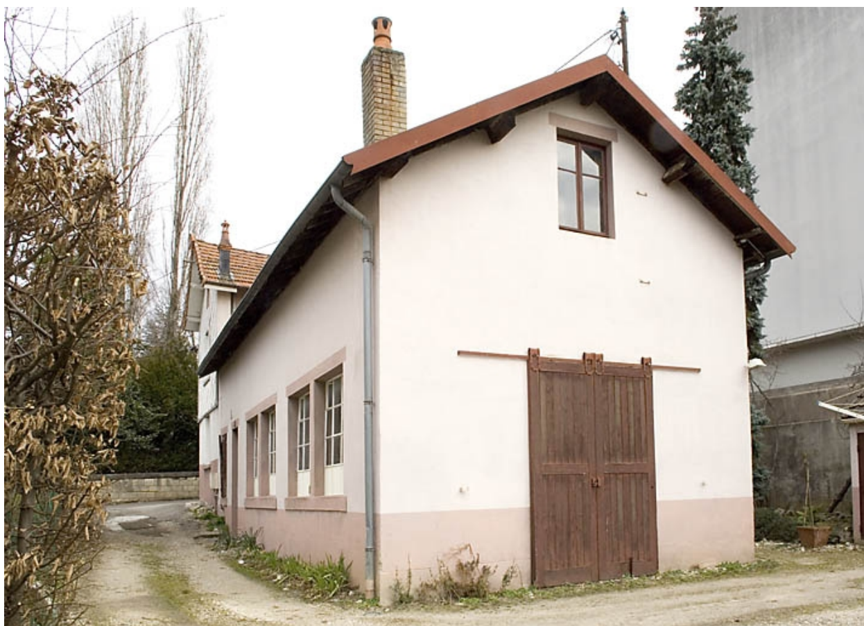
Atelier de fabrication vu depuis le sud-ouest.
