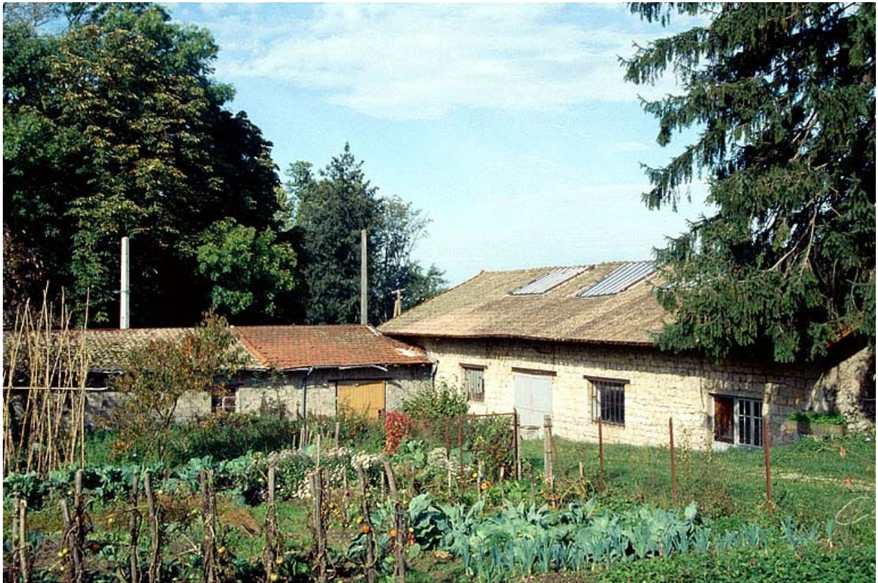
Atelier de fabrication depuis le sud-est.
