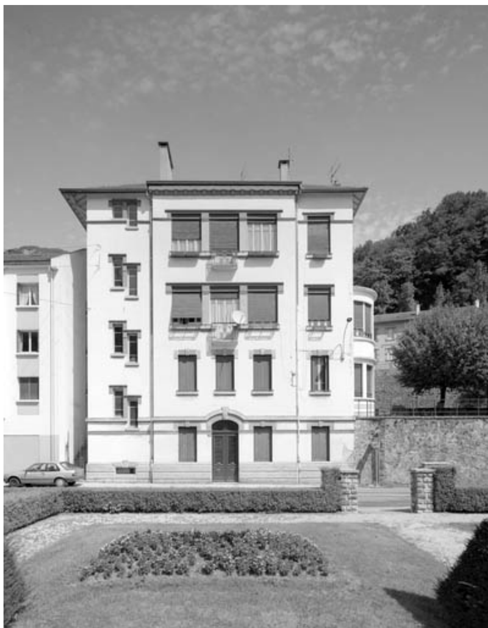
Façade du 2e bâtiment.
