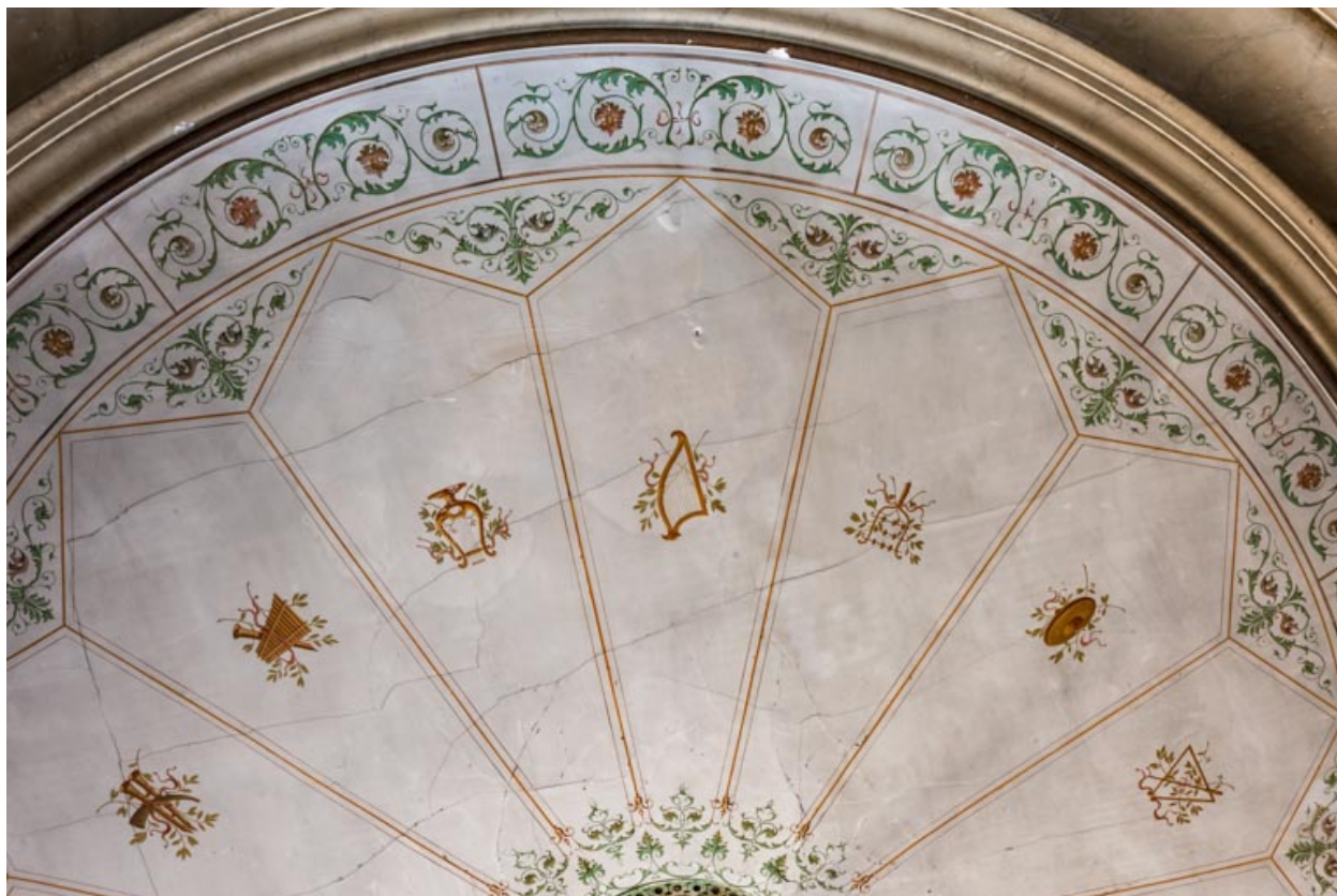
Peinture du plafond : détail.
