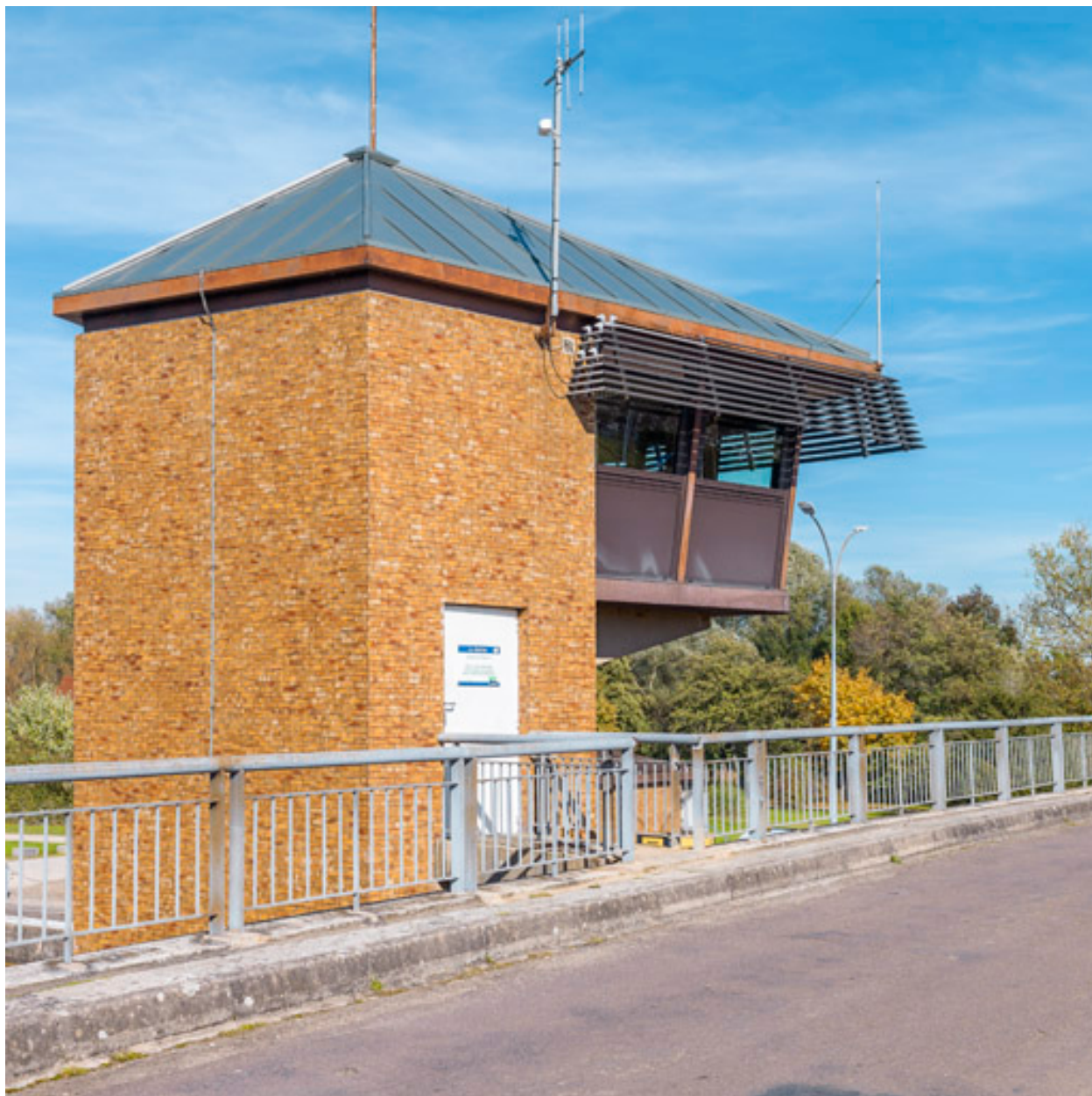
Vue rapprochée de la tour de contrôle.
