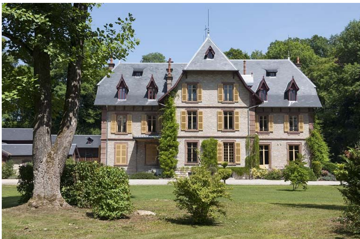
Façade antérieure vue de face.
