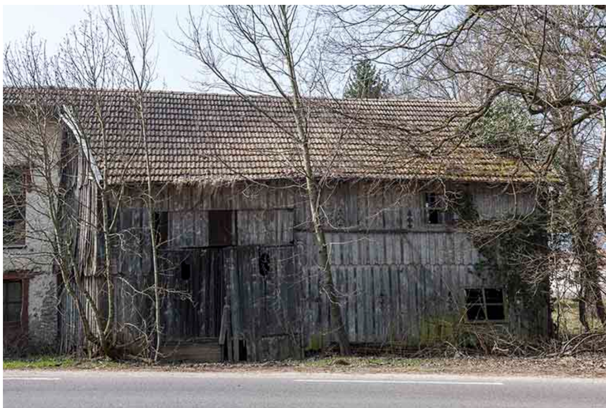
Façade est de l'entrepôt industriel.
