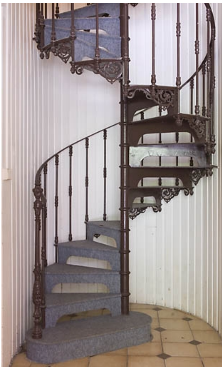
"Grand Château" : escalier métallique en vis.
