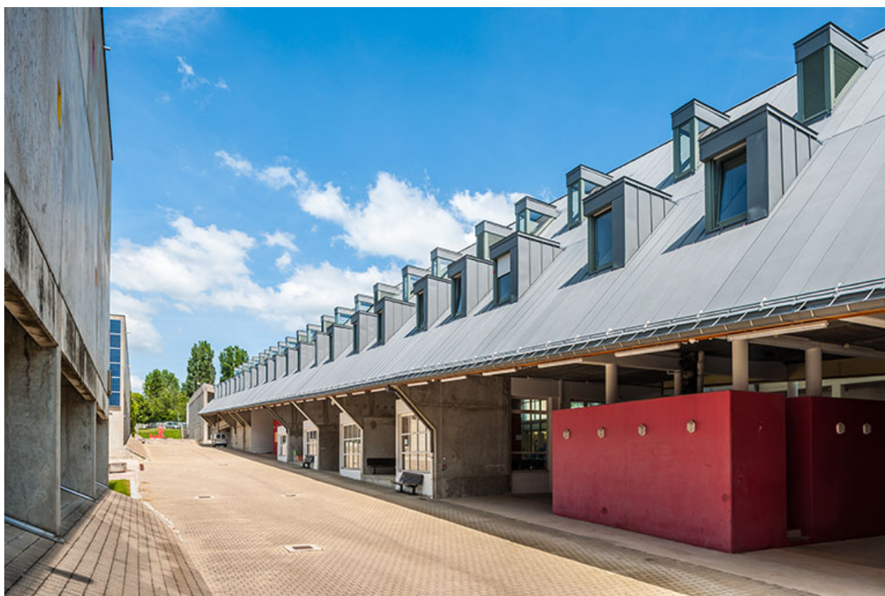
Façade sur rue intérieure du bâtiment internat - administration : toiture métallique avec chien-assis
