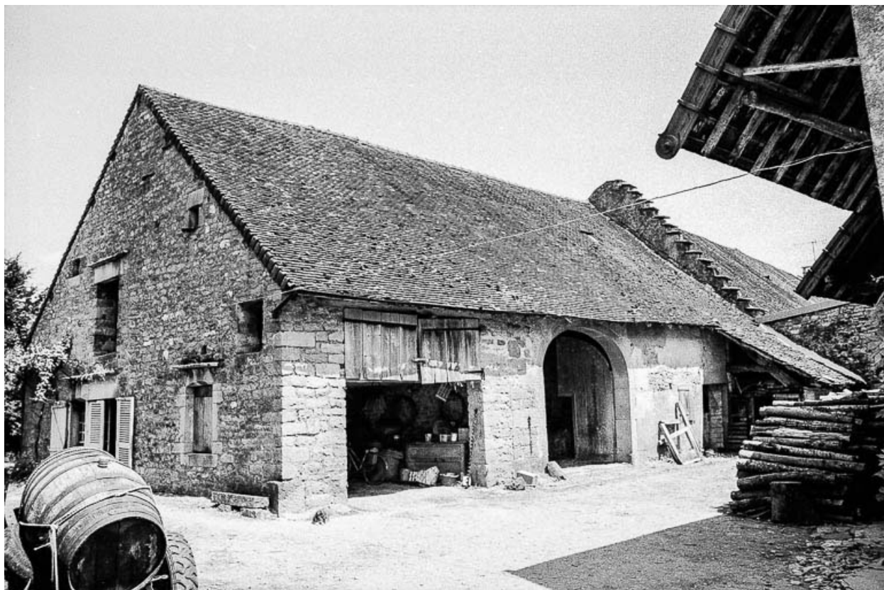
Fermes situées 324-326 rue d'Oisenans : bâtiments d'exploitation.
